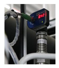
Tradicionalmente, los sistemas de DX CO2 han sido controlados por recalentamiento. El cálculo de recalentamiento se basa en una medición de temperatura y es un sistema de control bastante lento. El control de calidad de vapor es un sistema de medición inmediata que permite una mayor presión de succión y una mejor COP. El ahorro de energía típico es del 15-20 %
